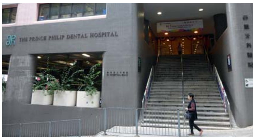
Abbildung Außenfassade des Prince Philip Dental Hospital, Universität Hongkong, Sai Ying Pun, Hongkong (November 2017).
