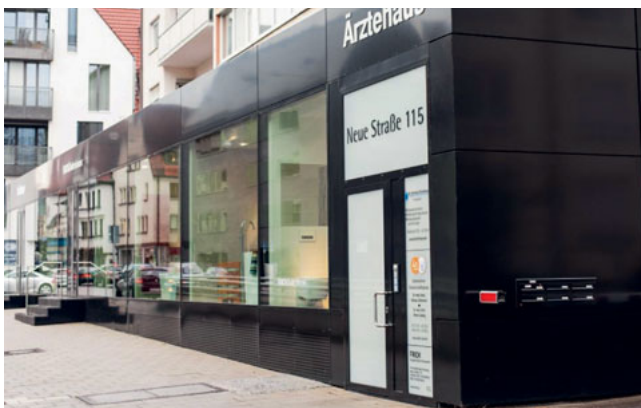
Abb. 1.1 Im Außenbereich der Praxis ermöglicht ein breiter Bürgersteig das Ein- und Aussteigen direkt vor dem Praxiseingang.
