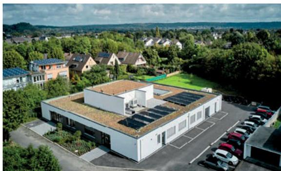
Abb. 1 Im Zuge des Laborneubaus wurde beim „Dentalstudio Sankt Augustin“ alles neu gedacht - auch und vor allem hinsichtlich des Themas Nachhaltigkeit. Holzbauweise, überwiegende Stromerzeugung via Photovoltaikanlage, Rückgewinnung der Wärmeenergie aus den Kompressoren, Dachbegrünung und vieles, vieles mehr sorgten dafür, dass die Jury das Labor in der Kategorie „Best Lab“ mit dem „Green Dental Award“ 2025 auszeichnete.
